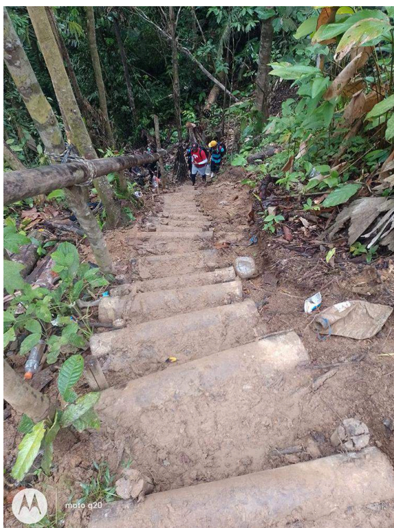
Fotografía 3: Escalones y barandas construidas por las comunidades en parte del camino a través de la selva
